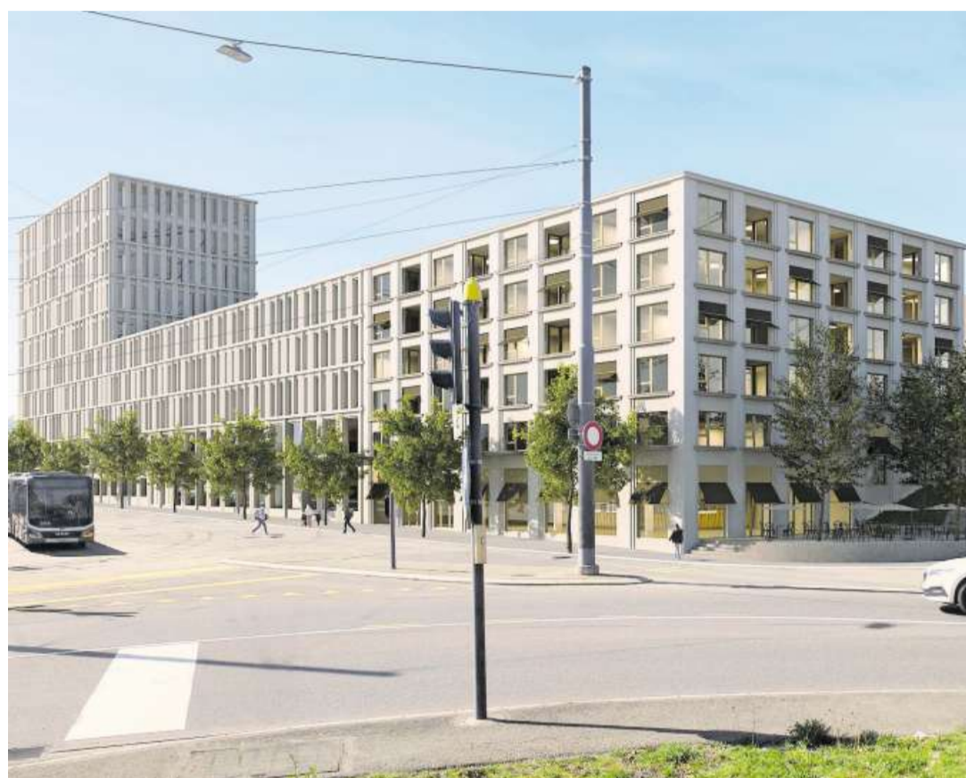
Das künftige Bahnhöfli ist der rechte Teil dieses Gebäudekomplexes, links anschliessend ist «Metropool» zu sehen, vorne die Seetalstrasse.
